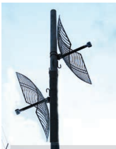
Figura 12. Montaje de las antenas en el Repetidor
